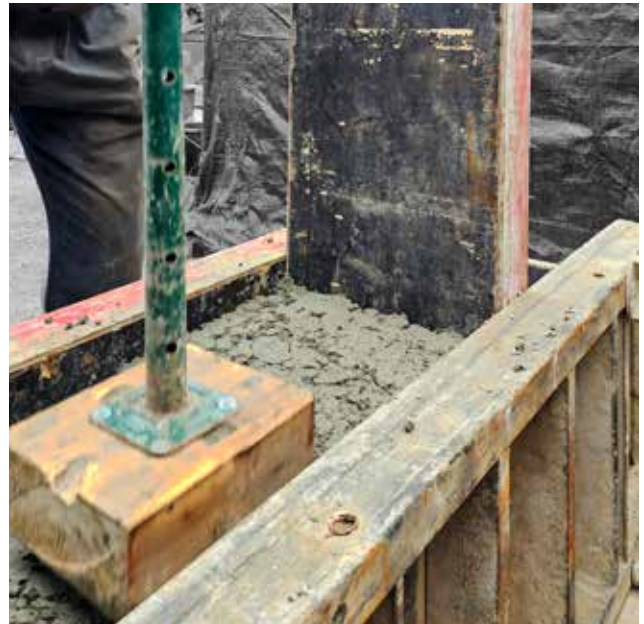
Proceso de apisonado tras el encofrado. Foto cedida por el autor.
